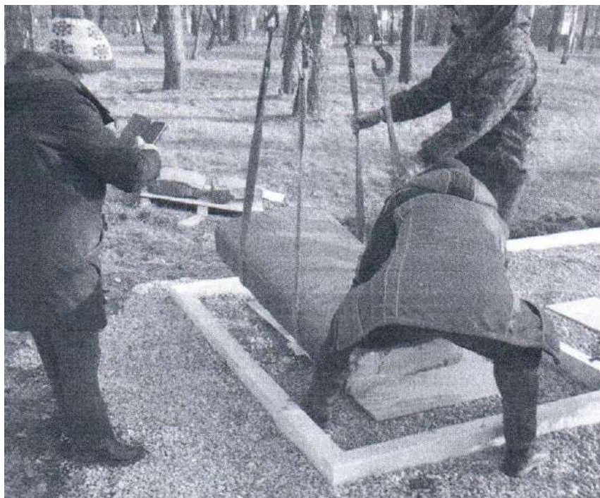
Установка надмогильной плиты на место постоянного размещения
